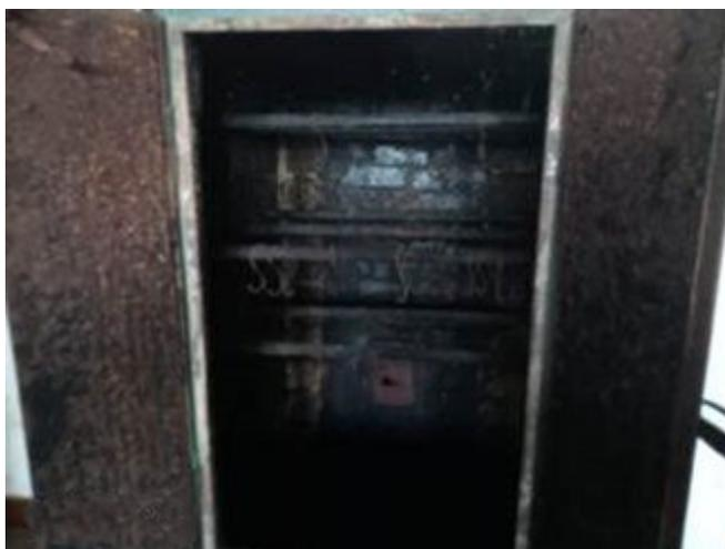
Bild 11: Eingebauter Räucherofen. Wurde zum Räuchern des Fleisches gebraucht, um es länger haltbar zu machen.
