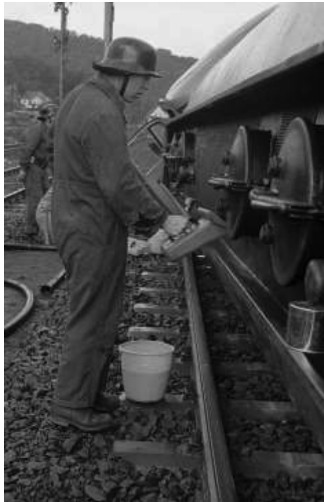
Abb. 5: Mit einer Ölschaufel fängt Hubert Schmidt aus den Lüftungsstutzen des Tanklasters austretendes Öl auf und füllt es in einen Eimer.
