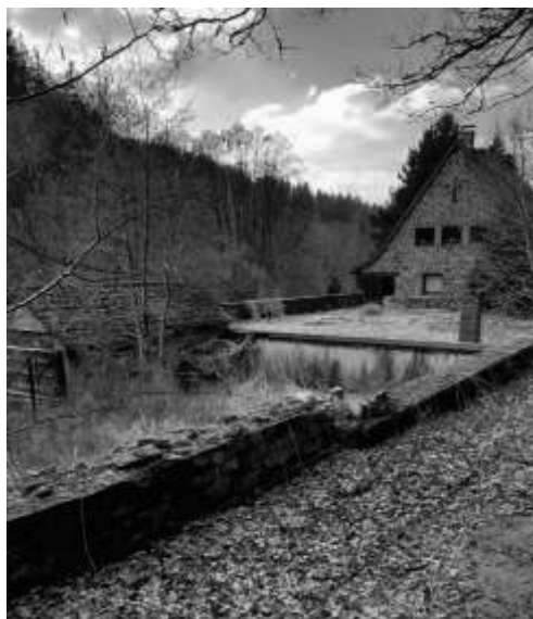
Abb. 21: Ehemalige Pumpstation und Wohnhaus der früheren Pumpenwärter, erbaut i.J. 1937.
