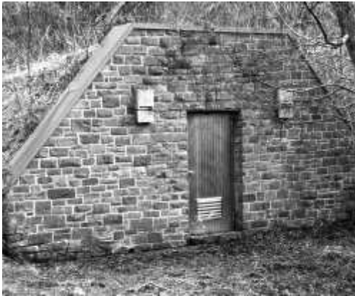
Abb. 7: Brunnenstube in Heilstein, erbaut in den 1990er Jahren.
